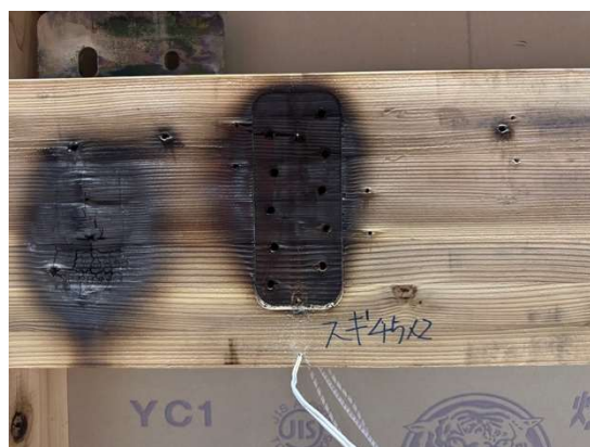
写真 3.1.3-3-16 解体時・梁スギ被覆 (試験体 3-2・仕様 3)
