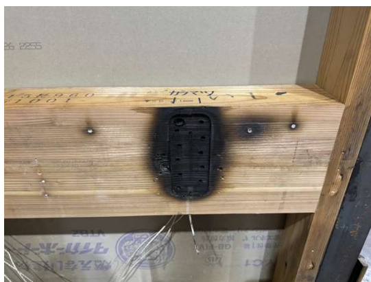
写真 3.1.3-1-13 解体時・梁カラマツ被覆 (試験体 1-1・仕様 2)
