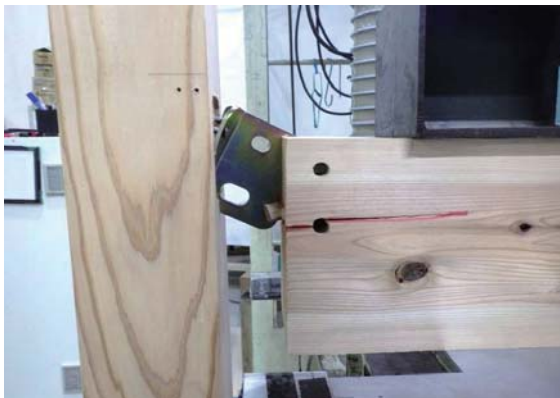
横架材の割れ(1. 2ch側)
