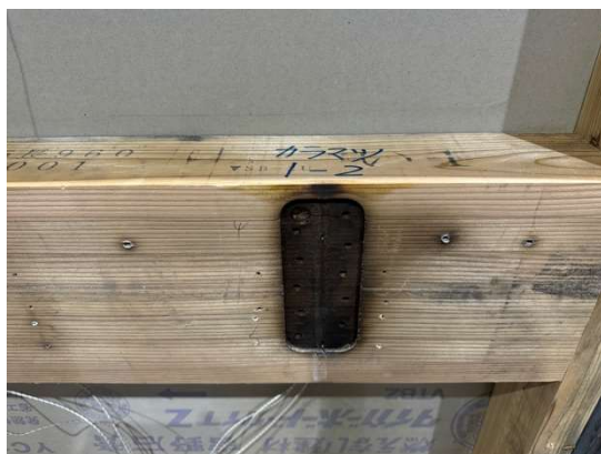
写真 3.1.3-1-17 解体時・梁カラマツ被覆 (試験体 1-2・仕様 4)
