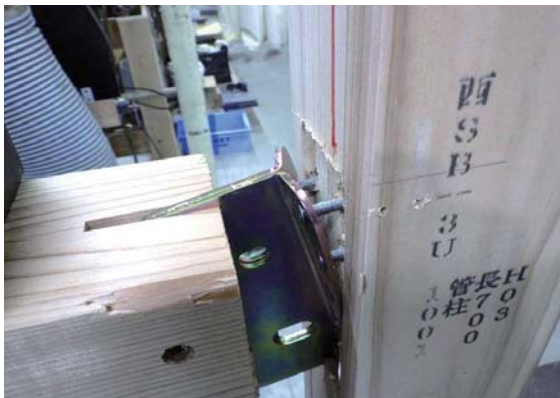
ねじの引抜け(1. 2ch側)
