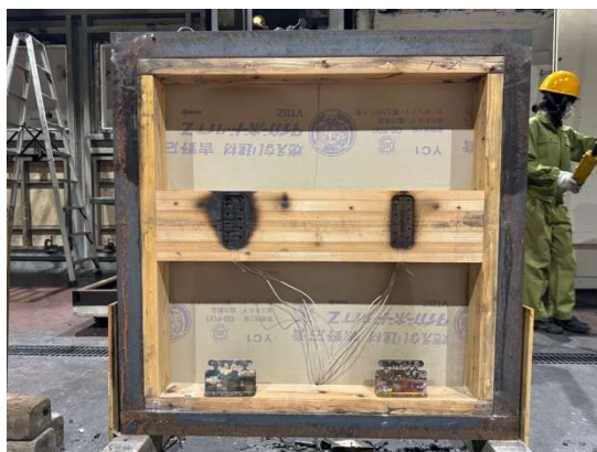
写真 3.1.3-1-15 解体時・梁表面 (試験体 1-2)
