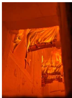
写真 3.1.3-2-1 加熱開始 50 分後・ボード剥離 (試験体 2-2)
