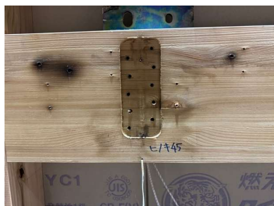
写真 3.1.3-3-12 解体時・梁ヒノキ被覆 (試験体 3-1・仕様 1)
