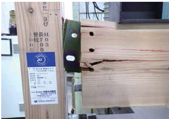
横架材の割れ(1. 2ch側)
