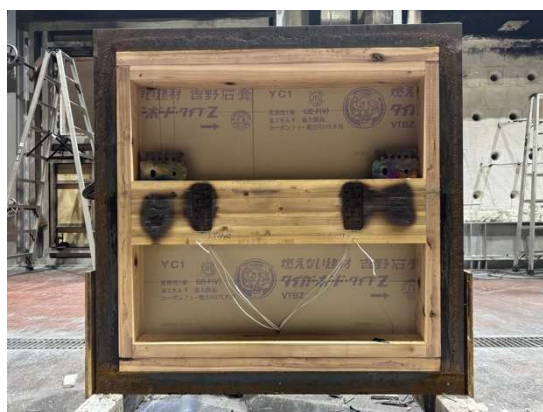
写真 3.1.3-3-15 解体時・梁表面 (試験体 3-2)
