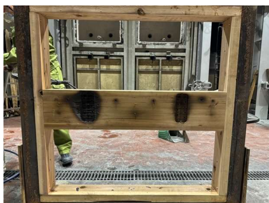
写真 3.1.3-2-1 解体時・梁表面 (試験体 2-1)
