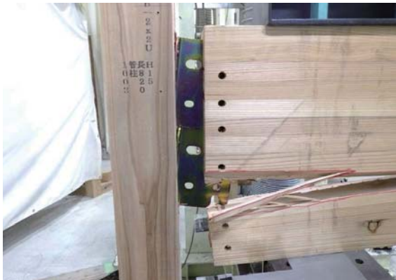
横架材の割れ (3. 4ch側)
