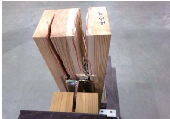
鉛直材の割れ (1. 2ch側)
