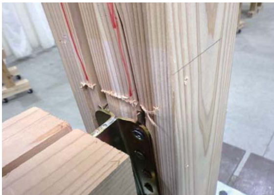
鉛直材の割れ (1. 2ch側)
