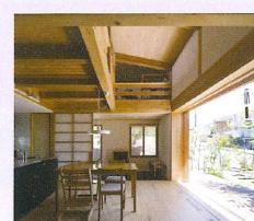
▶ 自然な陰影が魅力的な同社の施工例。自社で構造計算や建材加工も一貫して行うため、真壁造りでもコスト抑制を実現している。
