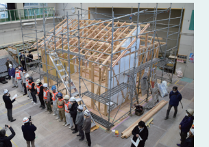
▶ 応急仮設住宅の建設講習会の様子
