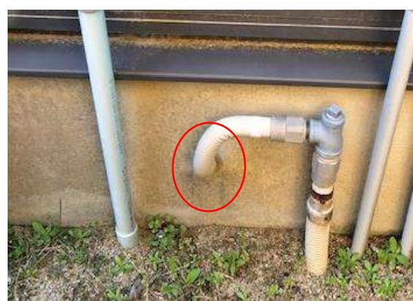
写真 3.2.8 ガス管の貫通部
