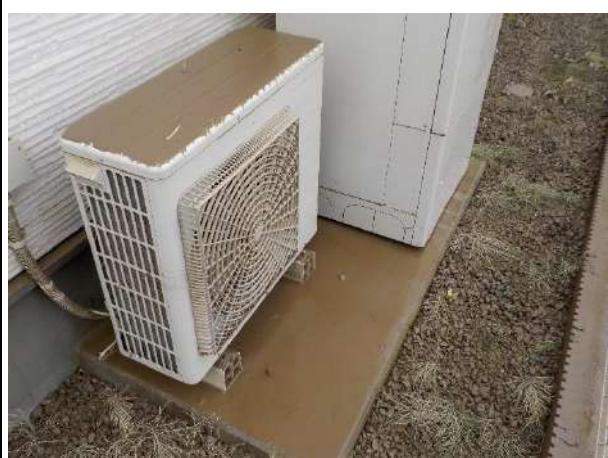
写真 3.1.2 屋外設備機器の浸水被害
