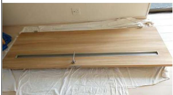
写真 3.1.10 内部建具の浸水被害
