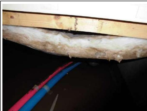
写真 3.1.5 床下断熱材の浸水被害
