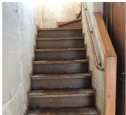
写真 3.1.8 階段の浸水被害
