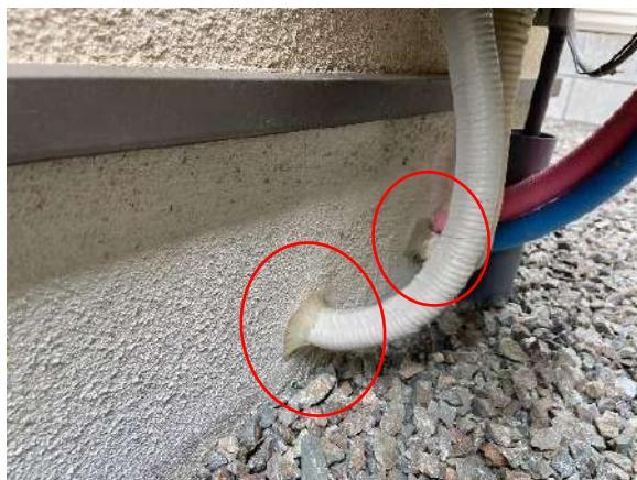
写真 3.2.7 給排水管の貫通部
