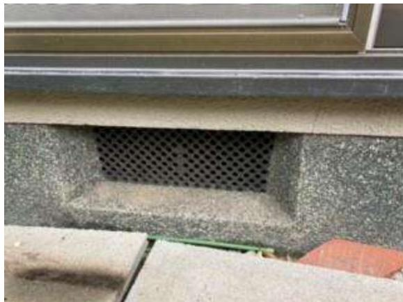
写真 3.2.1 基礎の床下換気口
