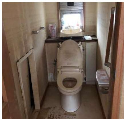
写真 3.1.11 住宅設備の浸水被害（トイレ）
