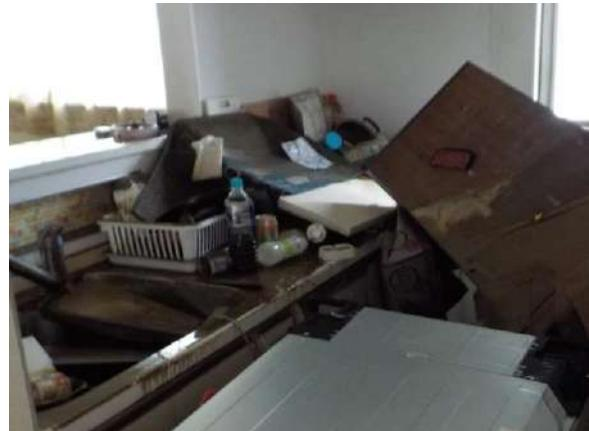
写真 3.1.12 住宅設備の浸水被害（キッチン）
