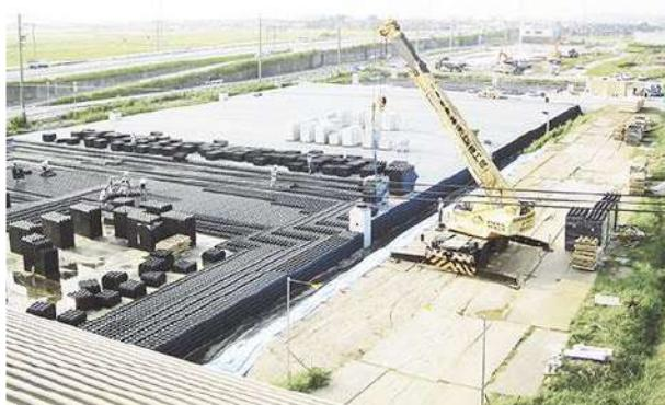
プラスチック雨水浸透槽「クロスウェーブ」
