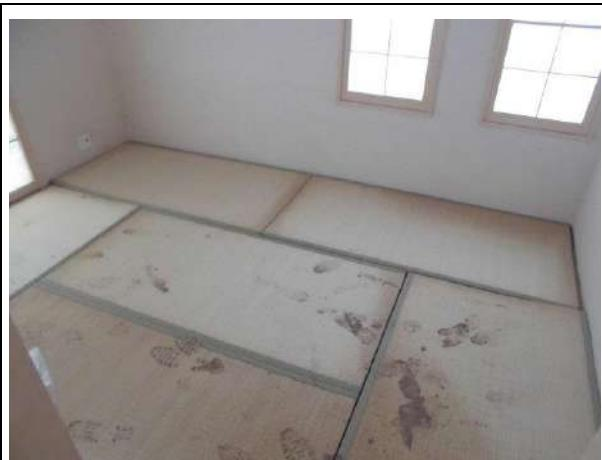
写真 3.1.6 和室の浸水被害
