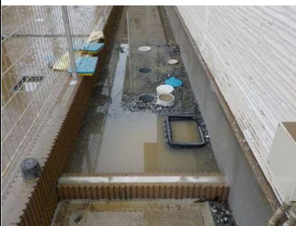
写真 3.1.4 外部配管の浸水被害
