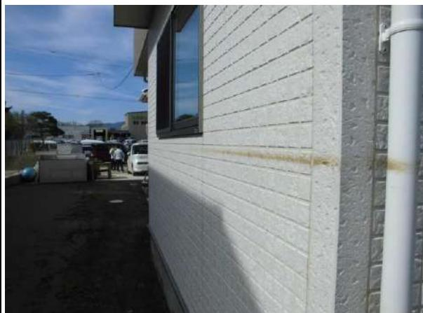
写真 3.1.14 外装材の浸水被害
