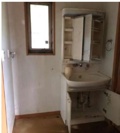
写真 3.1.13 住宅設備の浸水被害（洗面室）
