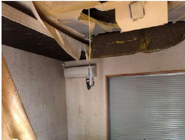
写真 3.1.16 天井の浸水被害
