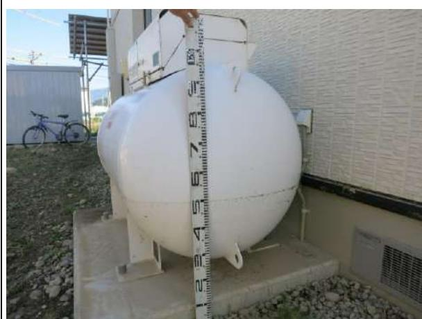
写真 3.1.3 屋外設備機器の浸水被害
