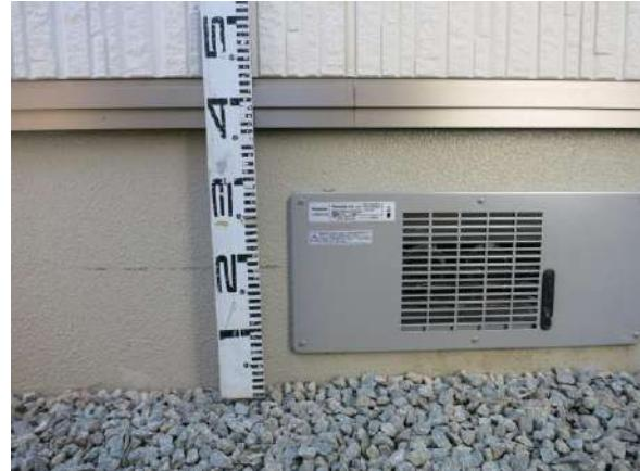
写真 3.2.2 基礎の床下換気扇
