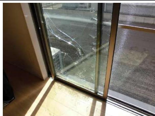
写真 3.1.15 窓の浸水被害（ガラス割れ）
