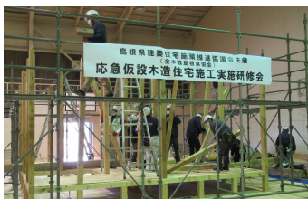
▲実習訓練 1月16日（島根県） 実技実施風景（建て方：作業開始）
