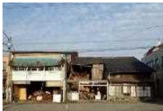
＜空き家の除却事例＞
