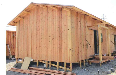
三春町で建設中の応急仮設木造住宅
