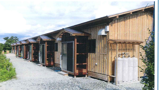
夏の暑さに耐え、厳しい冬を迎えようとしている応急仮設木造住宅は、寒さ対策のための追加工事も不要でした。
