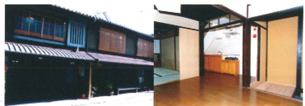
京町家改修モデルハウス「よしやまの町家」外観と内観
