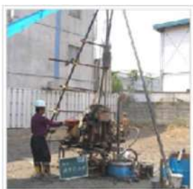
ボーリング調査
